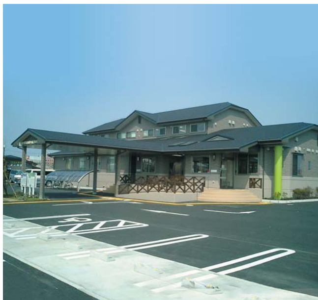
施工されたのは裏側にある診療室の屋根部分。
