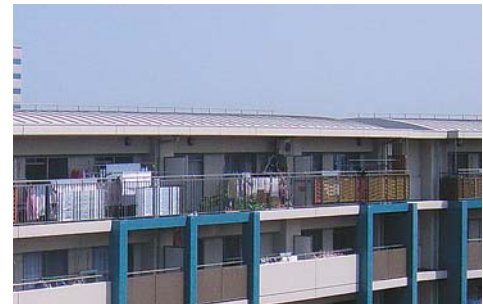
YKラインを設置したポールド屋根部分
