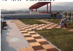
5.メンテナンス通路にプリオデッキの設置
