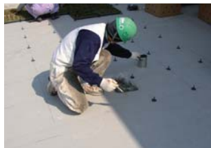
2.隅出しの後、PG固定ピンを設置
