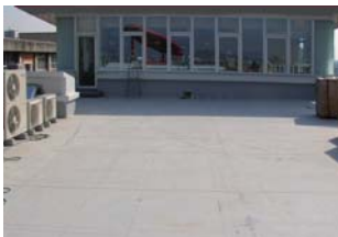
1.リベトルーフ防水施工完了
