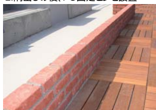
6.メンテナンス通路の立上がりレンガ設置
