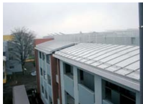
屋上軒先部( YKライン )
