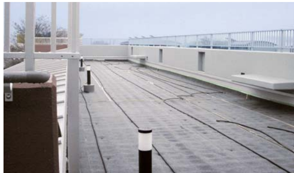
緑化施工前に行った基盤の飛散防止策
