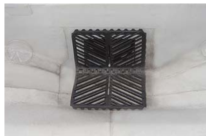
ドレン周辺部
