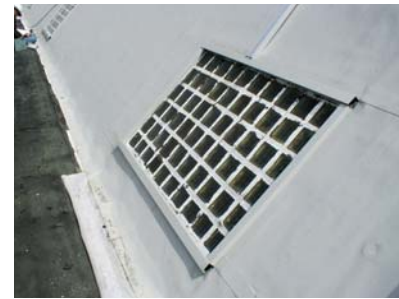
既存下地にあったガラスブロック製 (既存下地に埋込んである)の明かり取り
