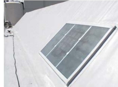
特注塩ビステンレス鋼板を作成し アクリル板(T=5mm)をはめ込んだもの
