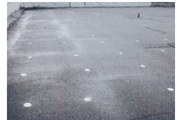
不陸調整用ディスク(GOディスク)固定
