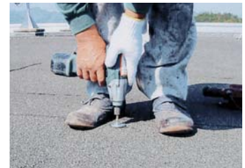
不陸調整用ディスク(GOディスク)設置
