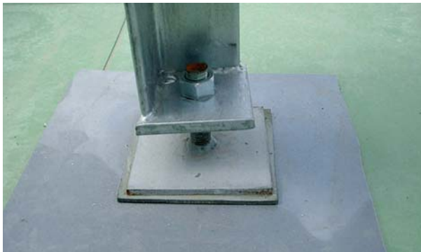
設備基礎部の処理
