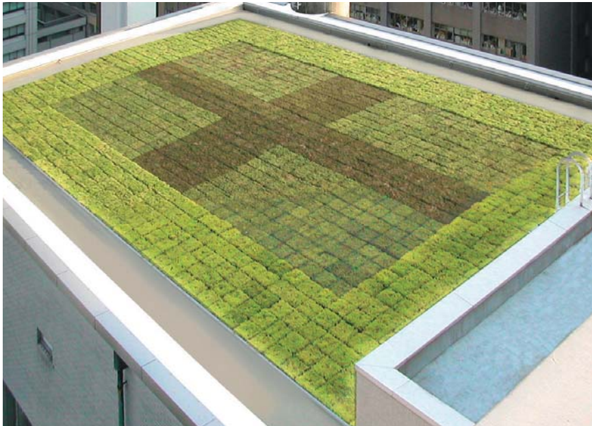
プリオセダム設置完了
