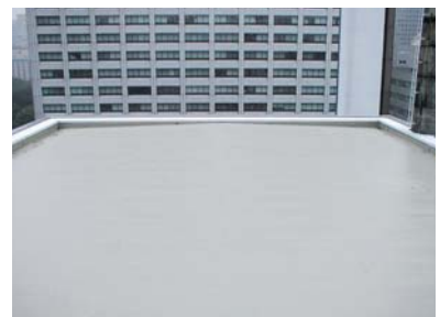
リベットルーフ施工完了
