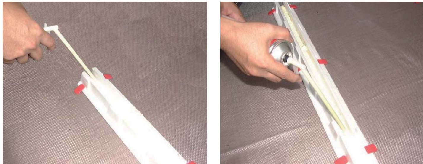
4-1.現場発泡ウレタン樹脂（下記参照）をベースの溝部に充てんする。
