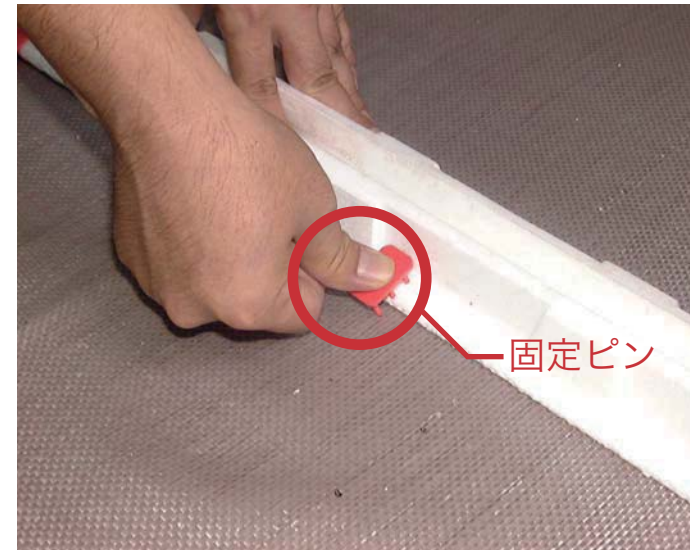
3-1. 固定ピンで、下地 (断熱材) に固定する。
