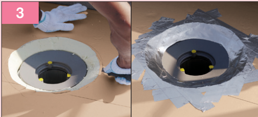
周辺断熱材の勾配調整し、ALジョイントテープ処理する
