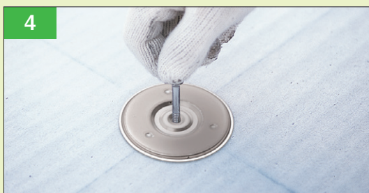
4 IHディスクの固定 （原則的にはその日のうちにリベットルーフを敷設できる範囲にすること）
