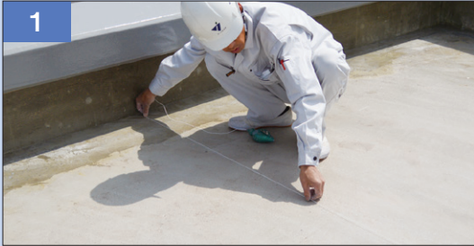
1 リベットルーフの墨出し
