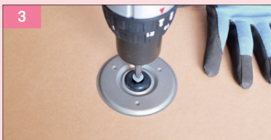
3 IH断熱ディスクの固定
