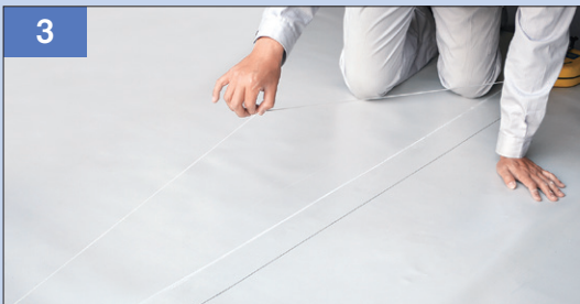
3 リベットルーフ裏面への墨出し
