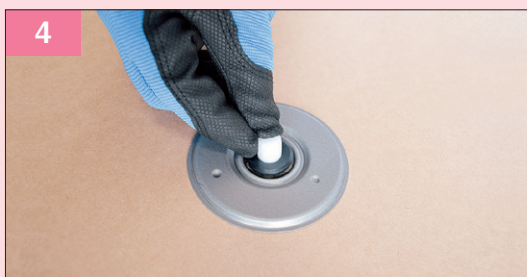
4 固定後チューブクッションを挿入する (原則的にはその日のうちにリベットルーフを敷設できる範囲にすること)
