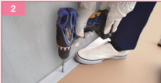
2 FL鋼板の取付け
