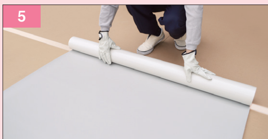
5 リベットルーフの敷設
