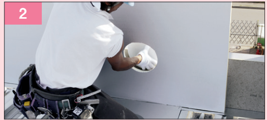
周辺断熱材の加工
