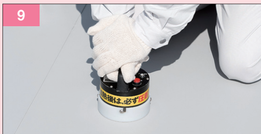
9 IHディスクの誘導加熱接合
