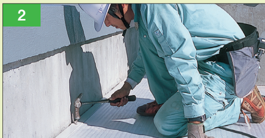
2 FL鋼板の取付け
