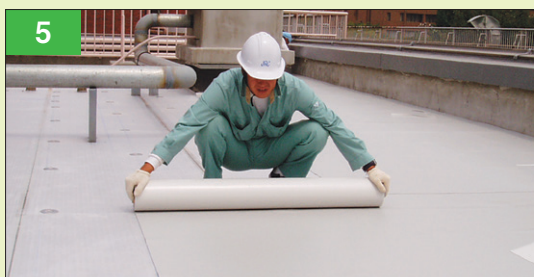
5 リベットルーフの敷設
